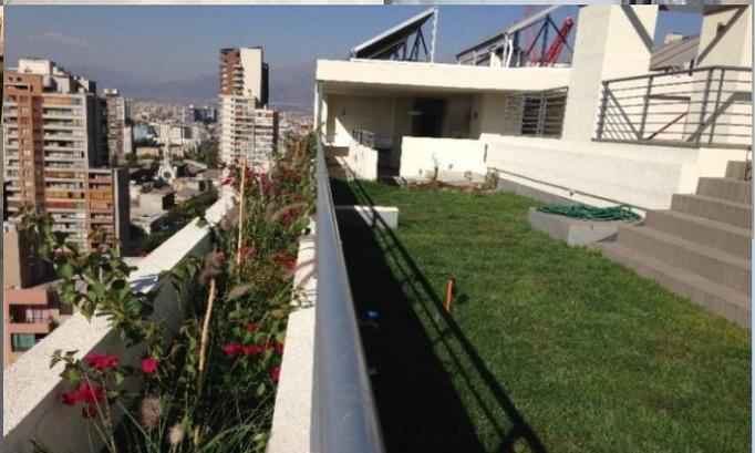
Impermeabilización y posterior ejecución de Cubierta Vegetal aljibe, ejecución año 2013, Santiago Centro, Chile.
